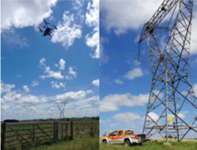
Fotografía 3 – Inspección con drones y sustitución de cadenas de 500 kV
